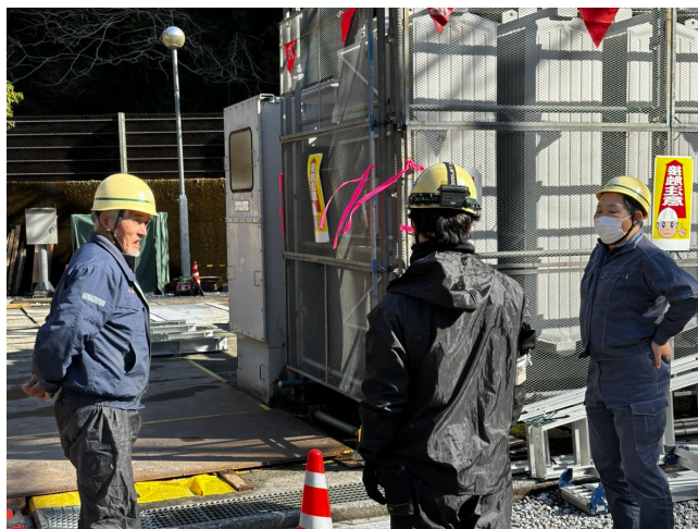
現場の進捗確認
